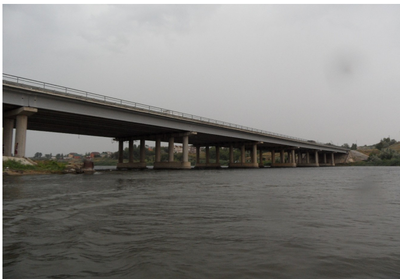
Фото 6. Автодорожный мост через залив Пичуга (Волгоградское водохранилище, Волгоградская область). (Фото Яковлев С.В.)
