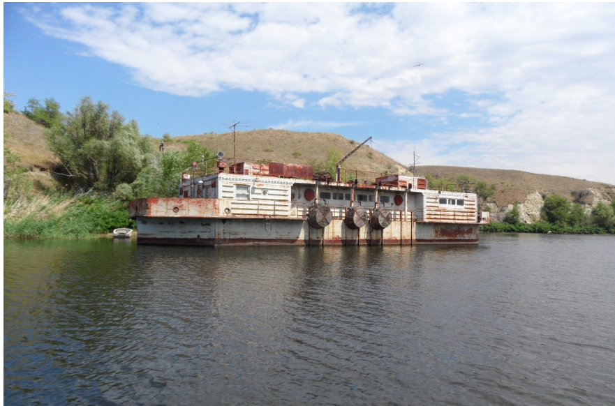
Фото 8. Плавучая насосная станция «Роса» в заливе Суводской (Волгоградское водохранилище, Волгоградская область). (Фото Яковлев С.В.)
