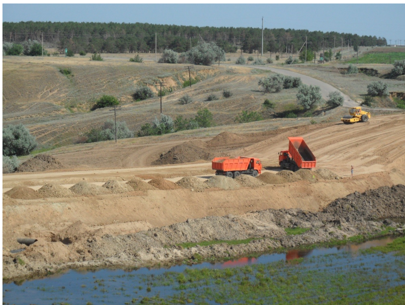
Фото 5. Строительство земляной дамбы на заливе Волгоградского водохранилища (Волгоградская область). (Фото Яковлев С.В.)
