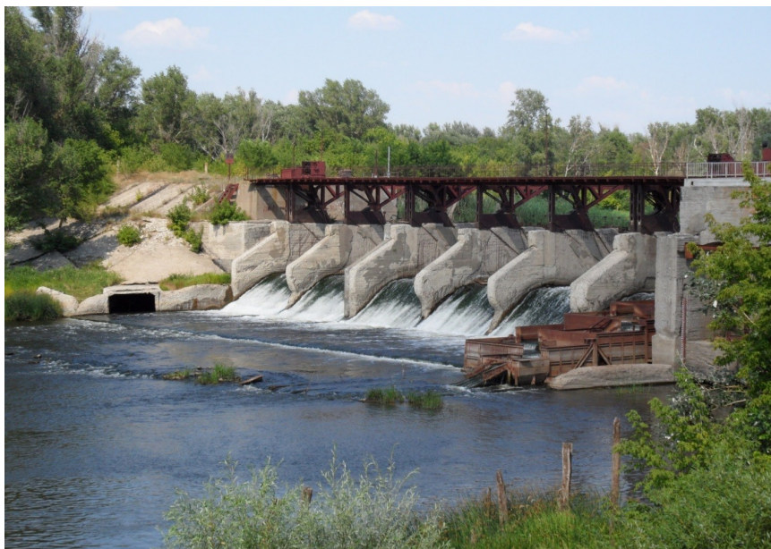
Фото 10. Малая ГЭС в пос. Красноярский на реке Медведица (Волгоградская область). (Фото Яковлев С.В.)
