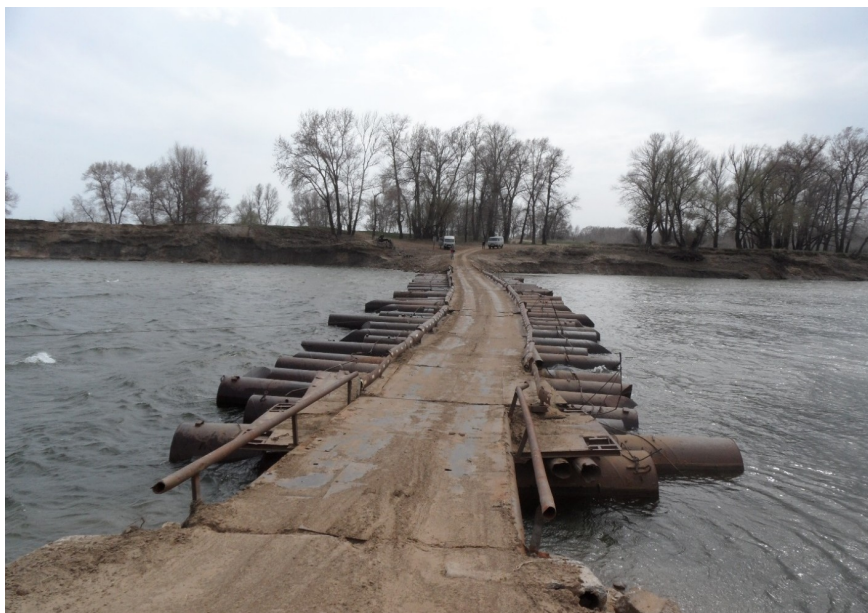
Фото 9. Понтонный мост в пос.Царев на реке Ахтуба (Волгоградская область). (Фото Яковлев С.В.)
