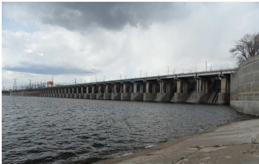
Фото 1. Гидростроительство (Волжская ГЭС, г. Волгоград). (Фото Яковлев С.В.)
