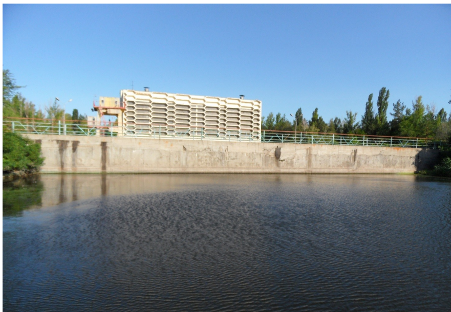
Фото 7. Стационарная насосная станция в заливе Ерзовский (Волгоградское водохранилище, Волгоградская область). (Фото Яковлев С.В.)
