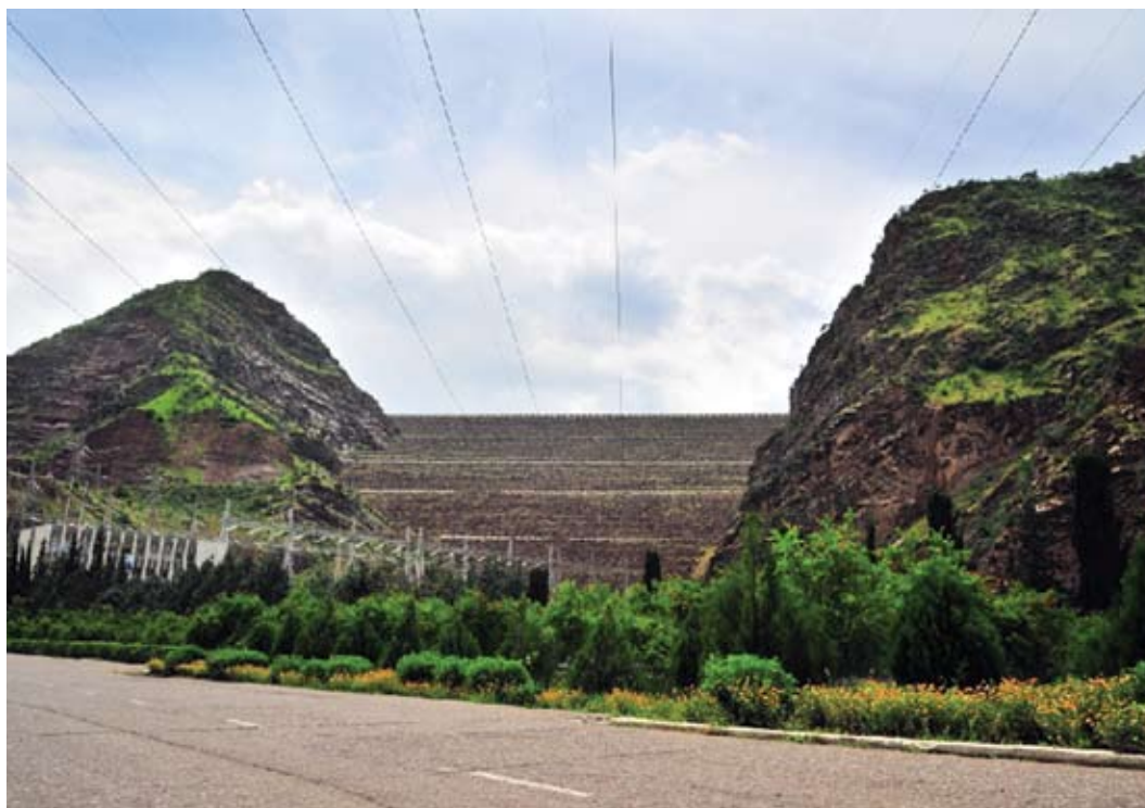
Рисунок 6. Плотина Нурекской ГЭС на реке Вахш
