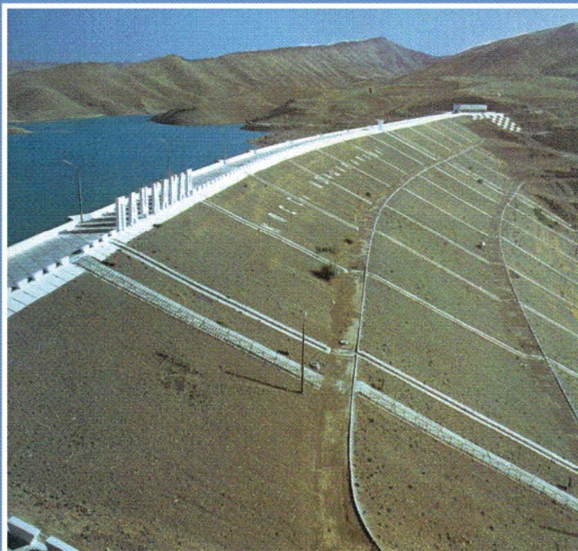
Рис. 17. Плотина Пачкамарского гидроузла на реке Гузардарья, Узбекистан (высота плотины - 71 м; объем водохранилища - 260 млн.м 3 )
