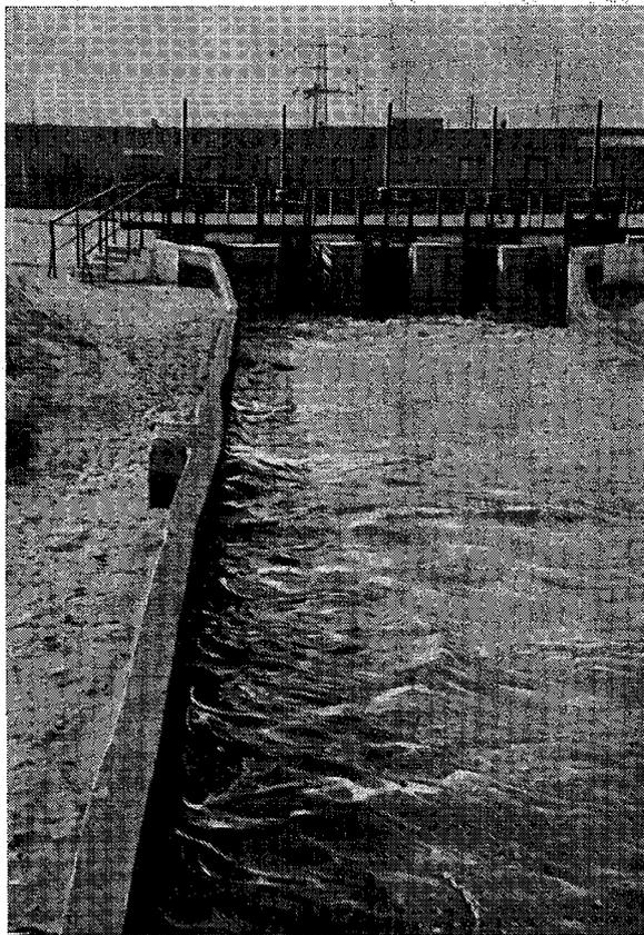
Рис. 11. Бортичская оросительная система под г. Киевом. Канал для подачи очищенных сточных вод на орошение.
