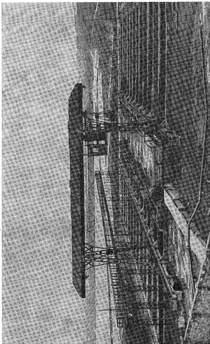
Рис. 1. Отстойник-маслоуловитель для промстоков Енакиевского металлургического завода.
