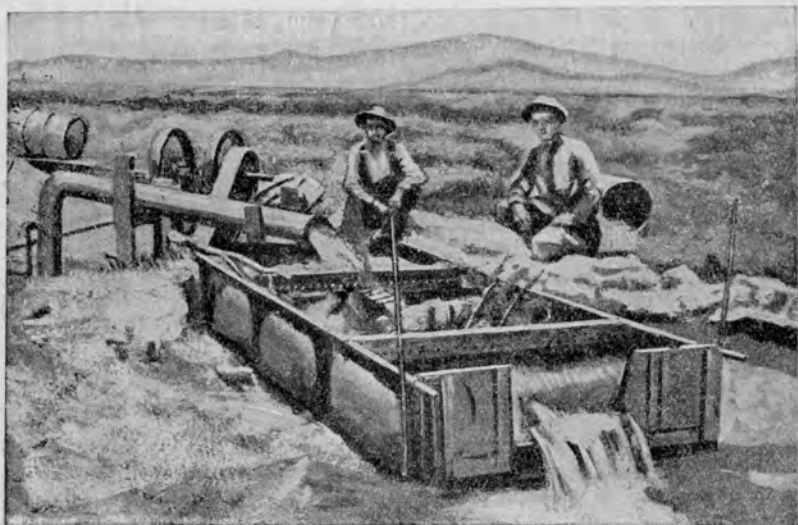
Рис. 48б. Складной водомер (по Мейнцеру и Кельтону).
