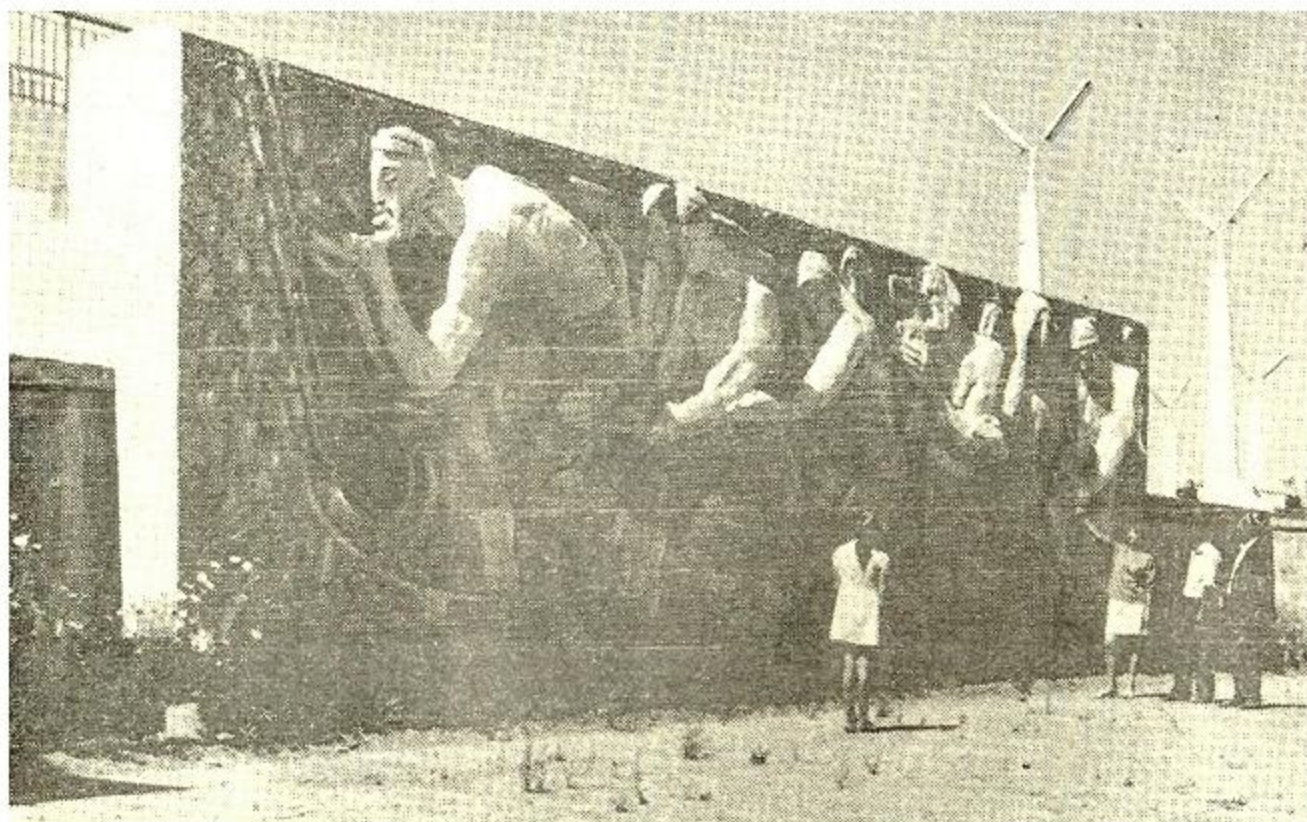
Фрагмент обелиска-мемориала на Аккарадарьинском гидроузле. A fragment of the memorial at the Akkaradarya headworks Fragment de l'obélisque mémorial érigé sur le complexe hydraulique d'Akkaradaria
