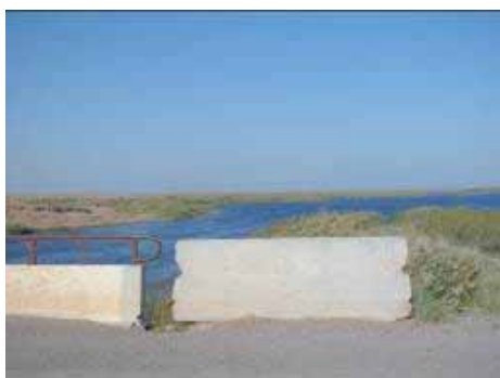
Рис. 3.3 Центральный Голодностепский коллектор (ЦГК)
