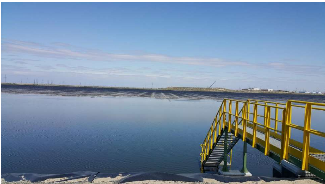
Фото 3. Бассейн-отстойник для техногенных вод юго-западнее посёлка ТШО
