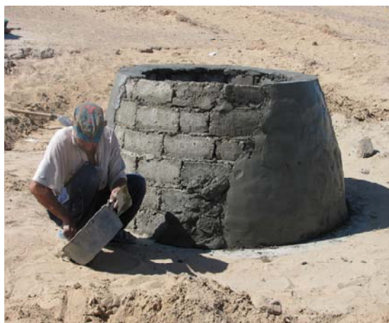
Рисунок 8 – Подготовка внешнего свода колодца
