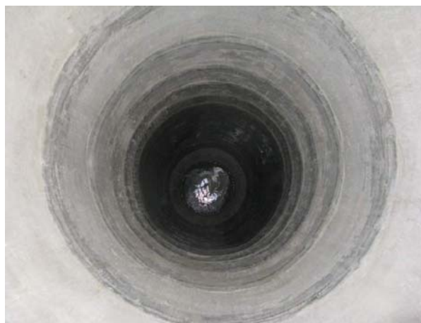
Рисунок 11 – Появление воды на глубине 18–20 м
