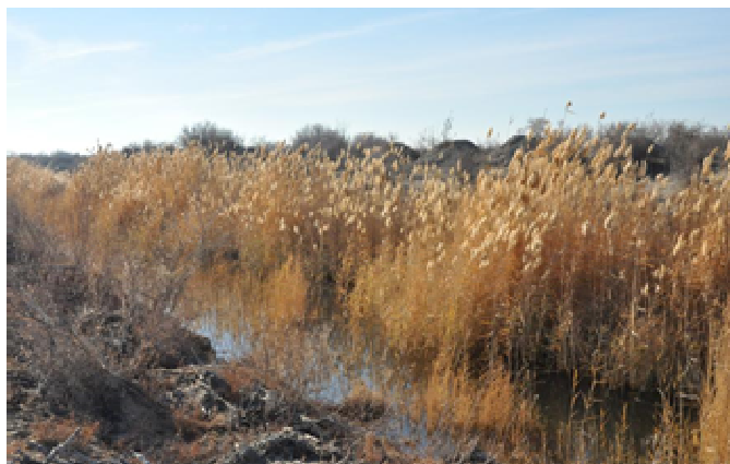
Рисунок 2 – Заросшее камышом русло коллектора
