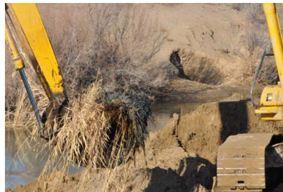
Рисунок 4 – Очистка коллектора от камыша
