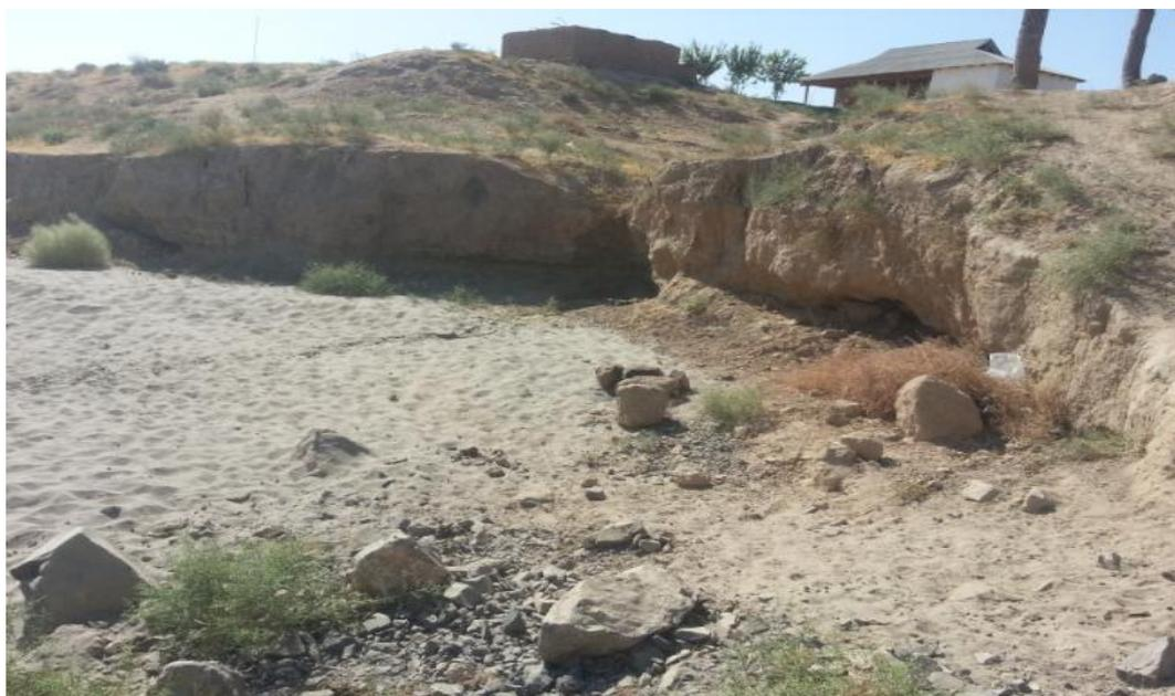
Рисунок 2 – Деформационные процессы за бетонированной частью подводящего канала.
