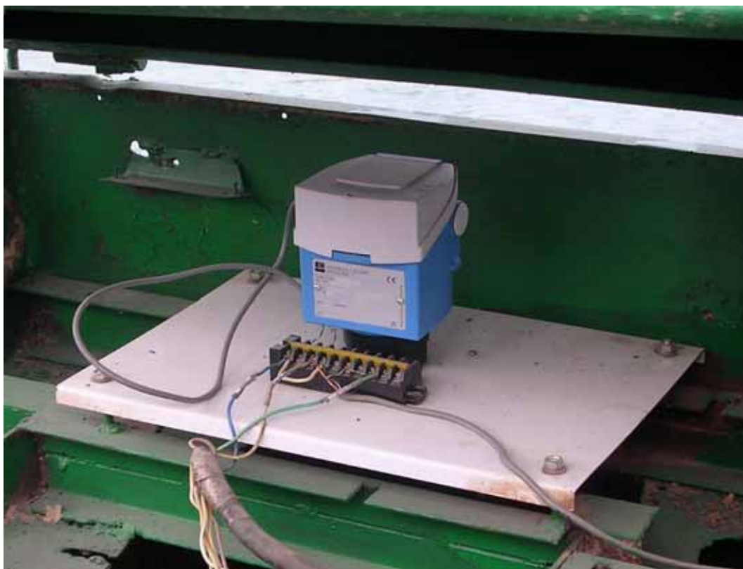
Рис. 1. Датчик уровня воды
