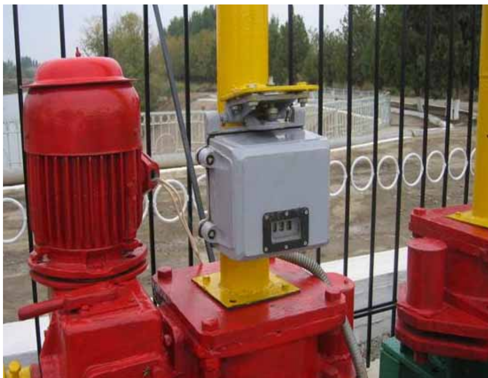
Рис. 4. Установка ДПЗ на винт затвора
