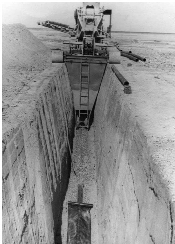
Рис. 1.23. Дреноукладчик с роющим органом и бункером, позволяющим вести укладку дрен в траншее трапецеидальной формы
