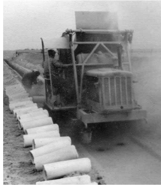
Рис. 3.15. Укладка дренажной линии из фасочных труб траншейным дреноукладчиком
