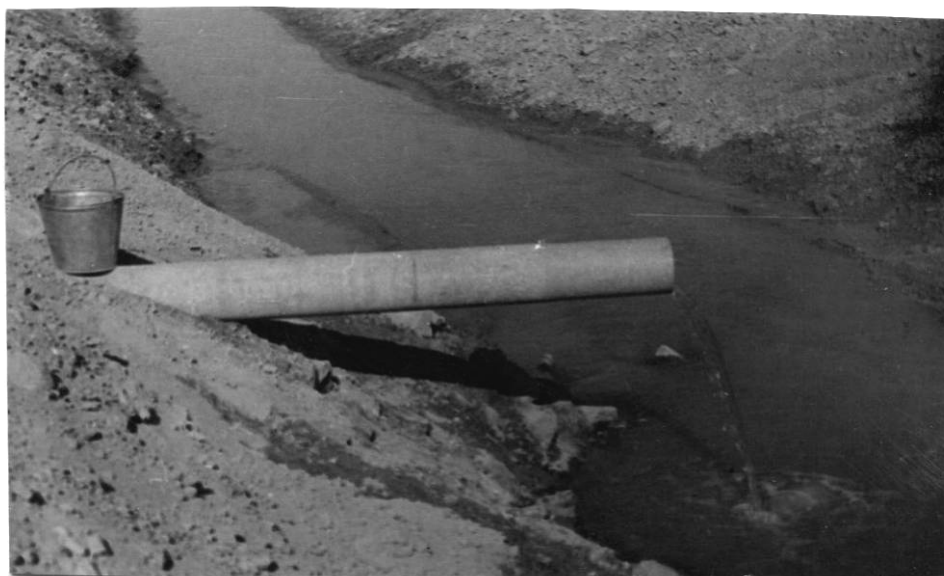
Рис. 1.7. Устье дрены в виде «консоли»
