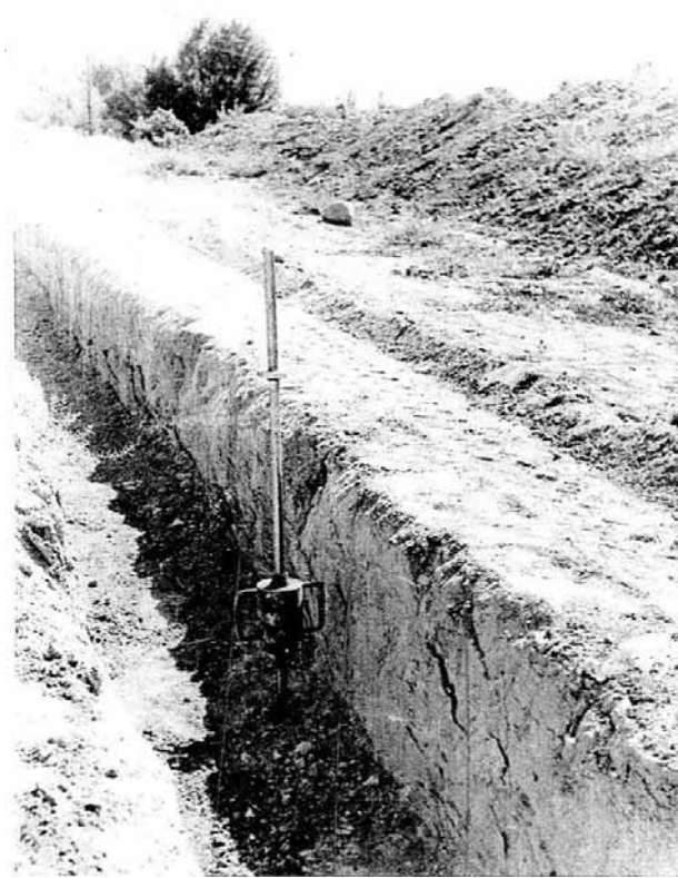
Рис. 4.30. Пенетромтр ДИИТ–4 погруженный в уплотненный грунт
