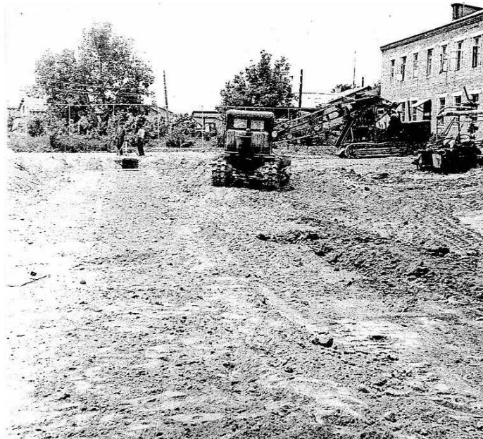
Рис. 4.31. Опытная дрена № 2 после засыпки и планирования наддренной полосы. Спереди виден контрольно–смотровой бункер
