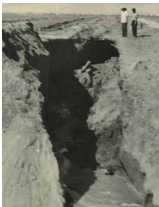
Рис. 2.4. Ирригационные эрозии приустьевой части дрен
