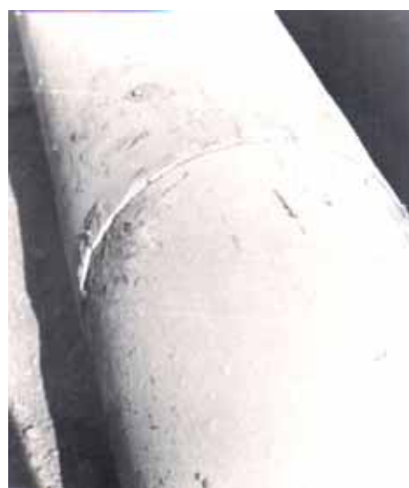
Рис. 3.14. Дренажная линия из фасочных труб до засыпки (а), стыковое соединение из фасочных труб (б)
