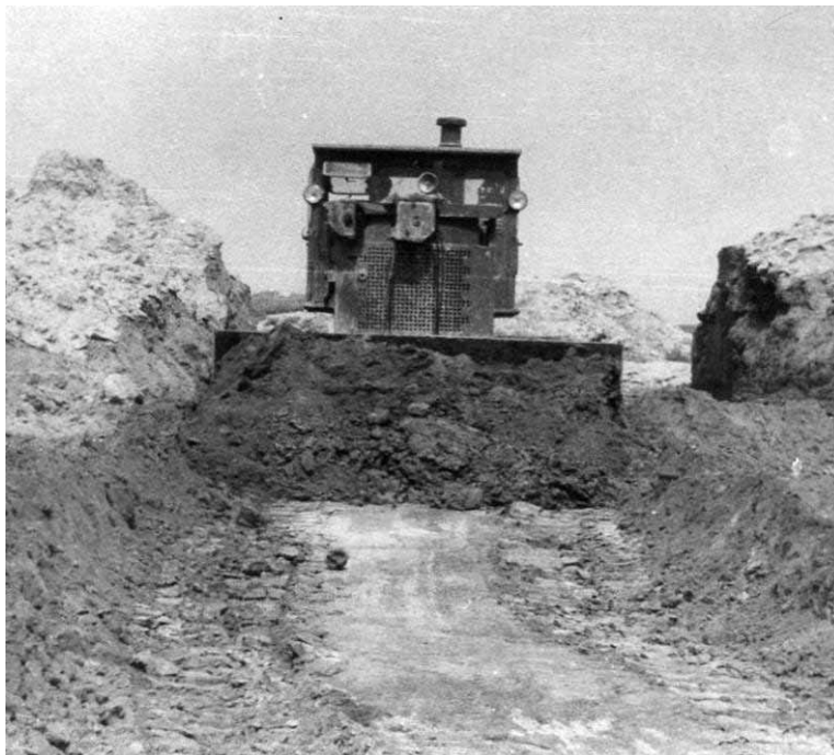
Рис. 1.21. Подготовка трассы дренаукладчика под заданный уклон дрены бульдозерами
