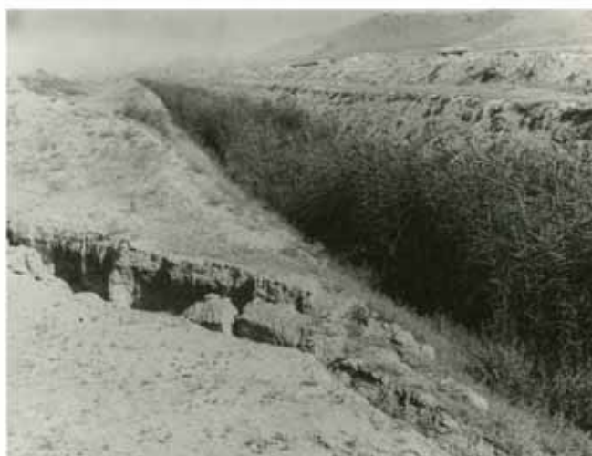
Рис. 2.4. Ирригационные эрозии приустьевой части дрен
