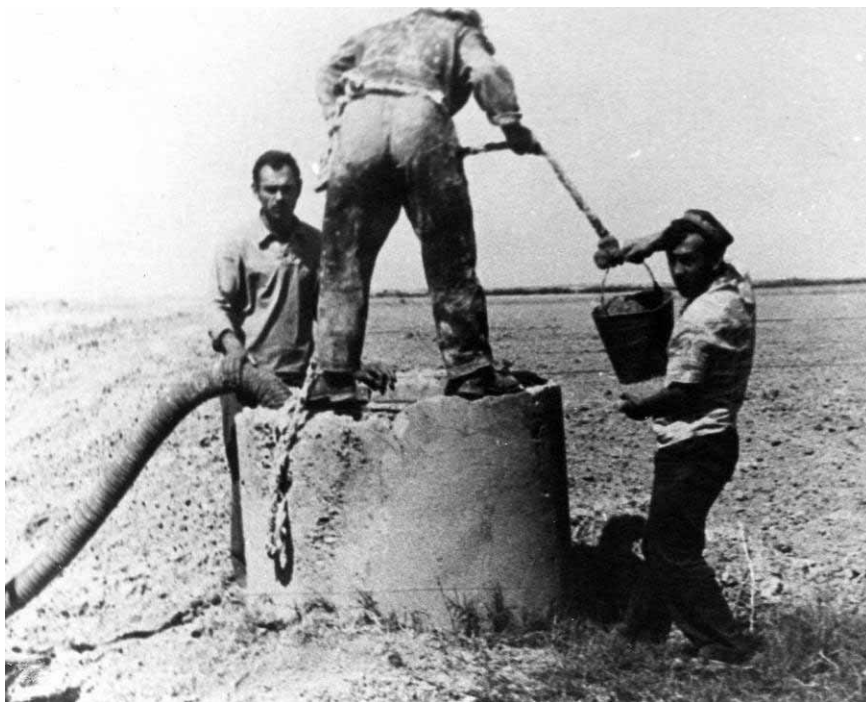
Рис. 3.27. Очистка смотровых колодцев бригадой рабочих
