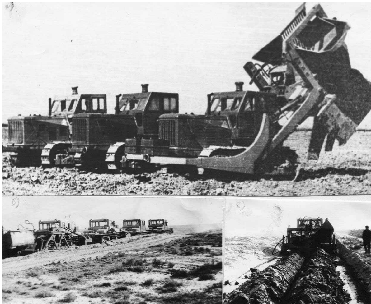
Рис. 1.25. Дреноукладчик БДМ-301
