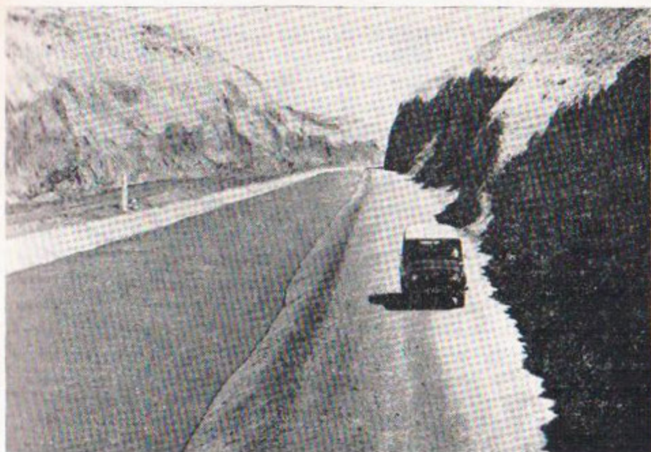
Р и с. 3. Бетонированный канал.
