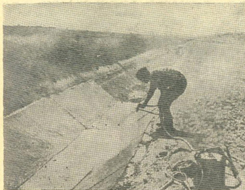
Рис. 30. Механизированное набрызгивание пленкообразующего покрытия.
