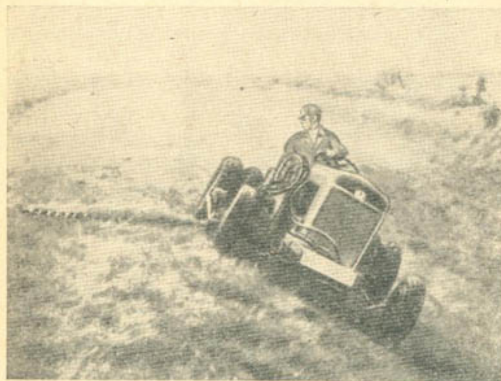
Рис. 22. Трактор Якобзен для окашивания откосов (ФРГ).
