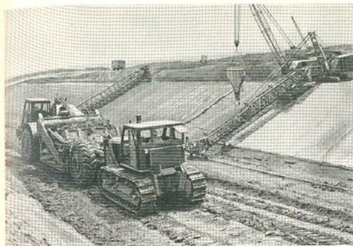
Рис. 72. Устройство облицовки канала из монолитного бетона по полиэтиленовой пленке.
