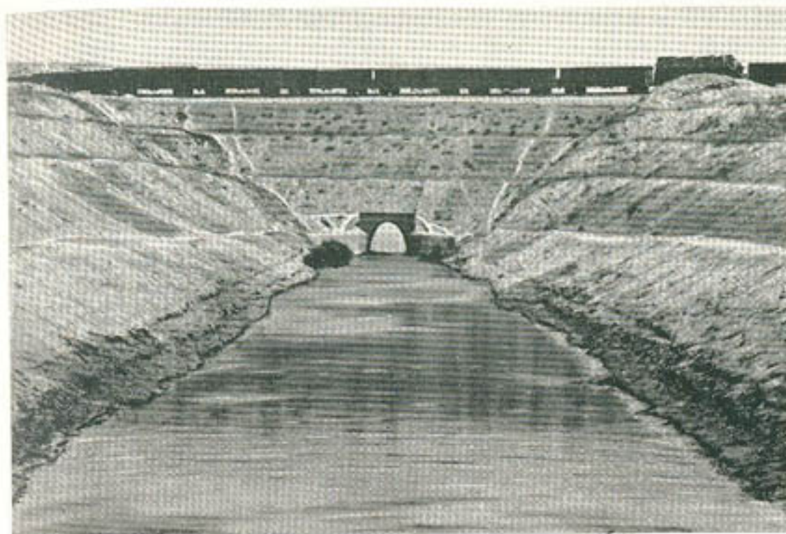
Рис. 46. Пересечение Главным Ширванским коллектором железной дороги на участке глубокой выемки.
