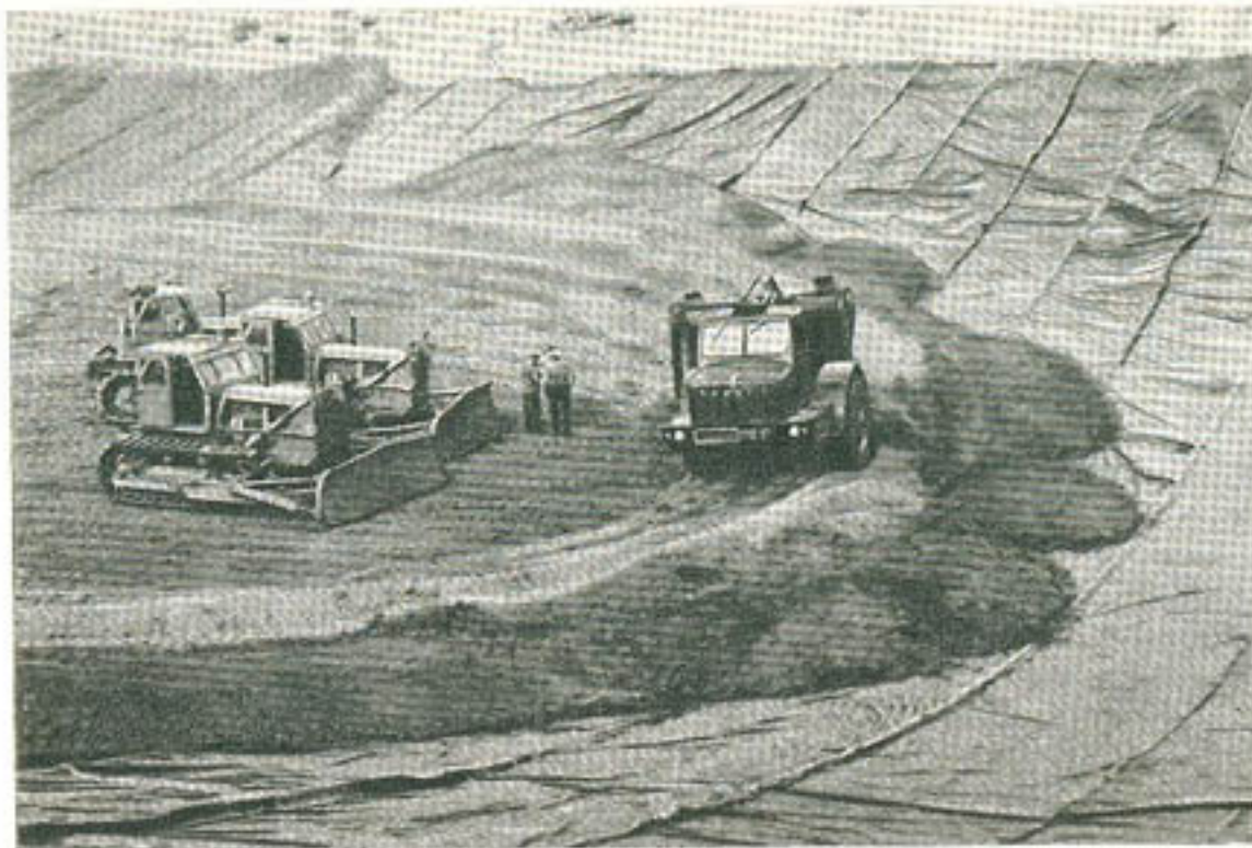
Рис. 26. Покрывание пленочного противодиффузионного экрана Главного Каховского магистрального канала защитным слоем суглинистого грунта.
