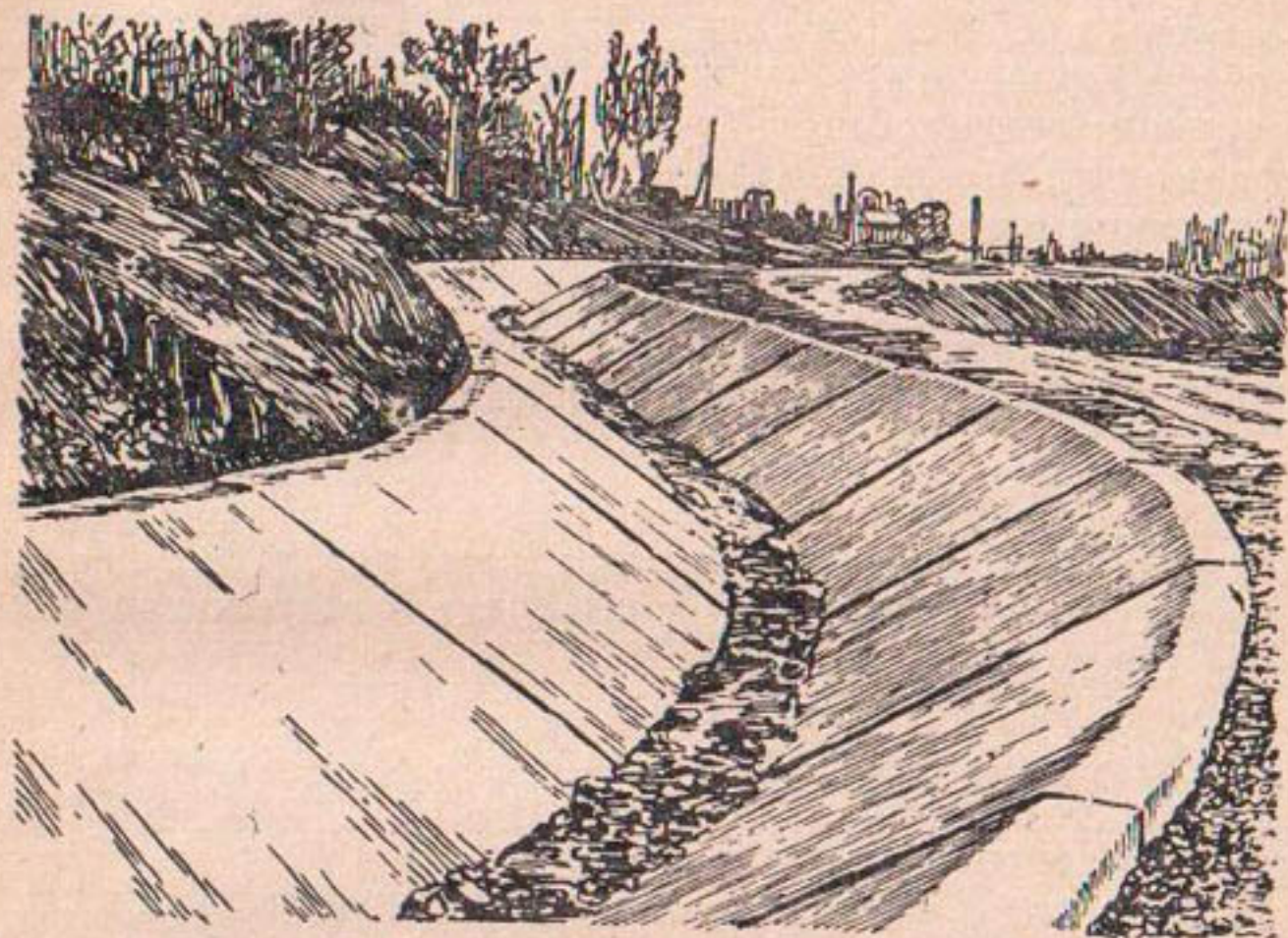
Рис. 33. Магистральный канал Салгирской оросительной системы в Крыму, облицованный армированным бетоном.
