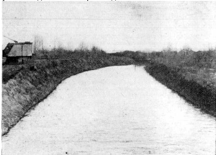
Рис. 80. Инфильтрационный канал на водозаборе из р. Томь
