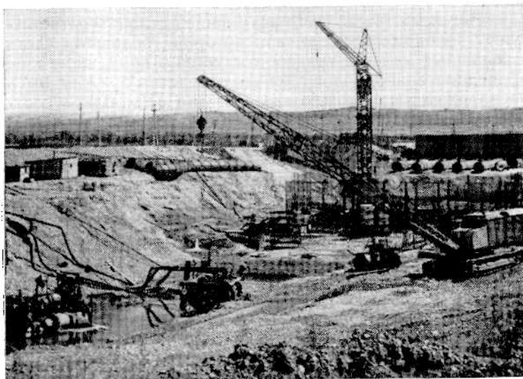
Рис. 6. Строительство ковшового водозабора на р. Томь
