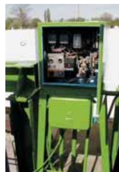
Рис. 2. Шкаф для местного управления затворами
