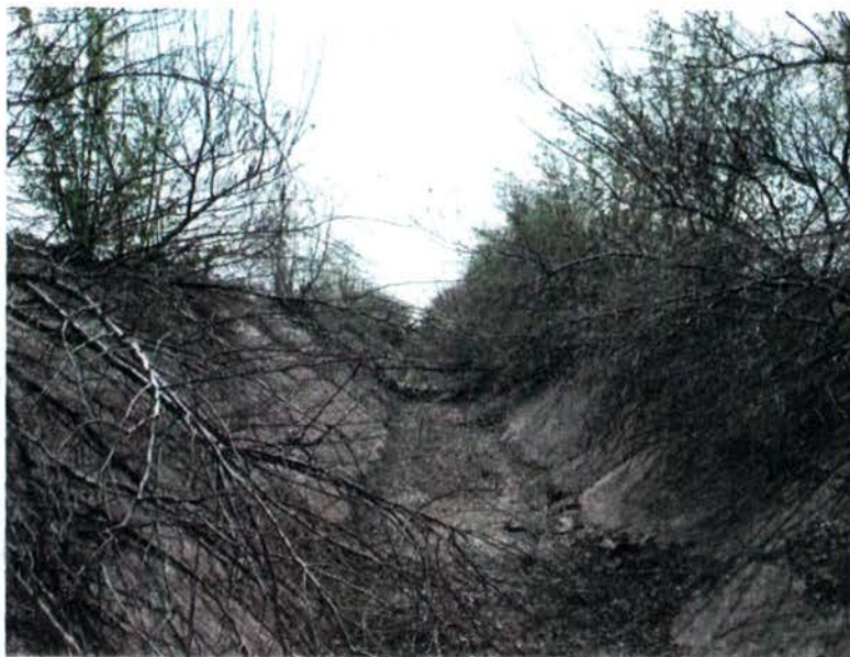
Рис. 1.14. Оросительный канал, заросший древесно-кустарниковой растительностью
