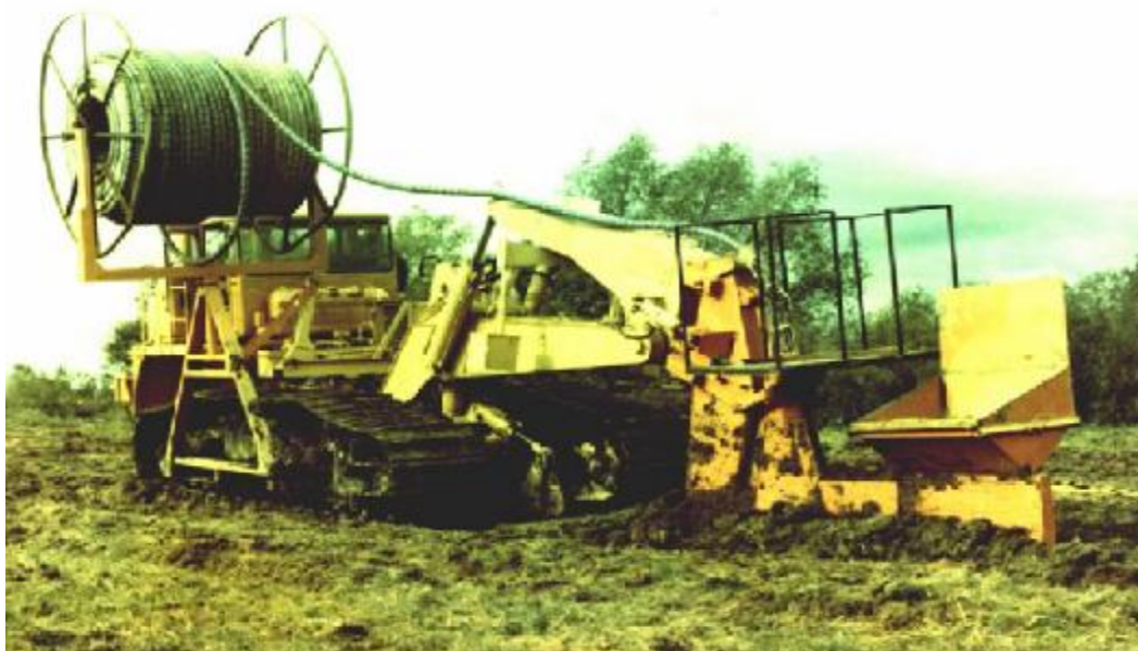
Рисунок 1 - Укладка дрены с фильтром из нетканого материала
