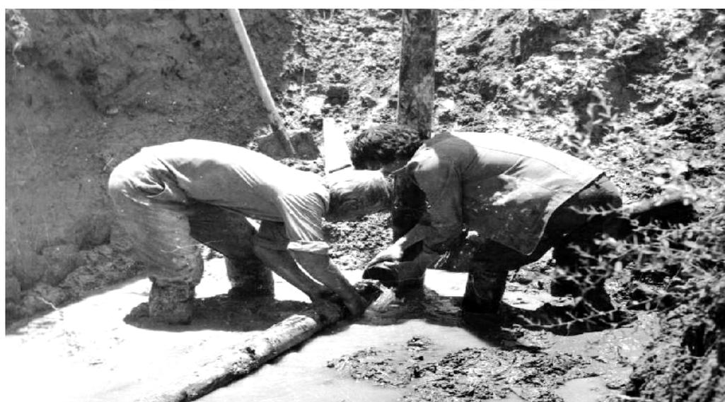
**Рис.19. Процесс подключения вертикальных скважин-усилителей к горизонтальной сети.**
