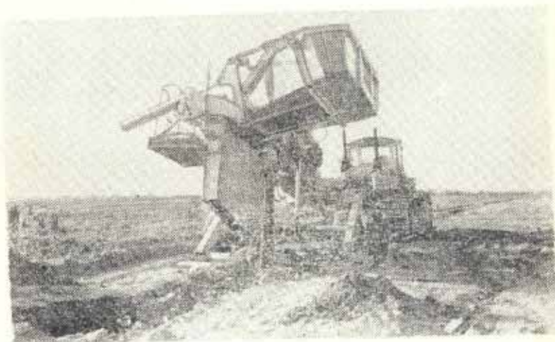
Дреноукладчик прицепной бестраншейный ДПБ-2,5
