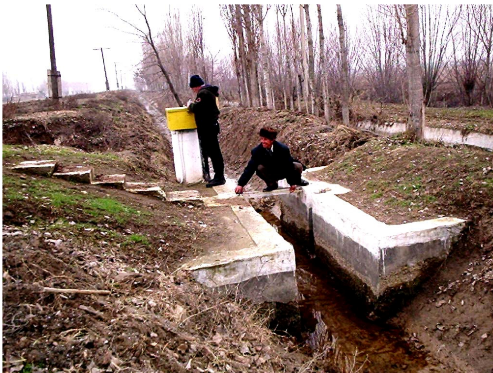
Рис. 7. Гидрометрический пост типа «фиксированное русло».
