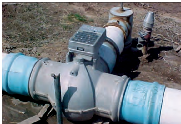
Рис. 9.5. Система дискретного (импульсного) полива с управляемым клапаном
