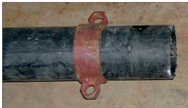
Рис.5.10. Установка хомута на трубе
