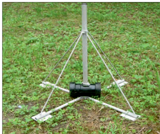
Рис. 5.8. Установка стояка в муфте
