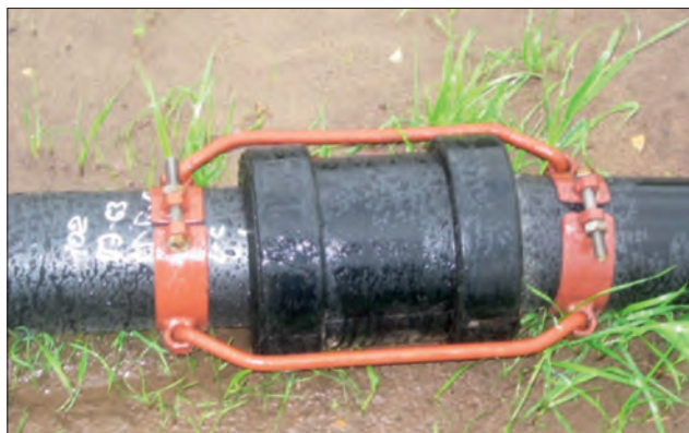
Рис. 5.5. Соединение труб в муфте
