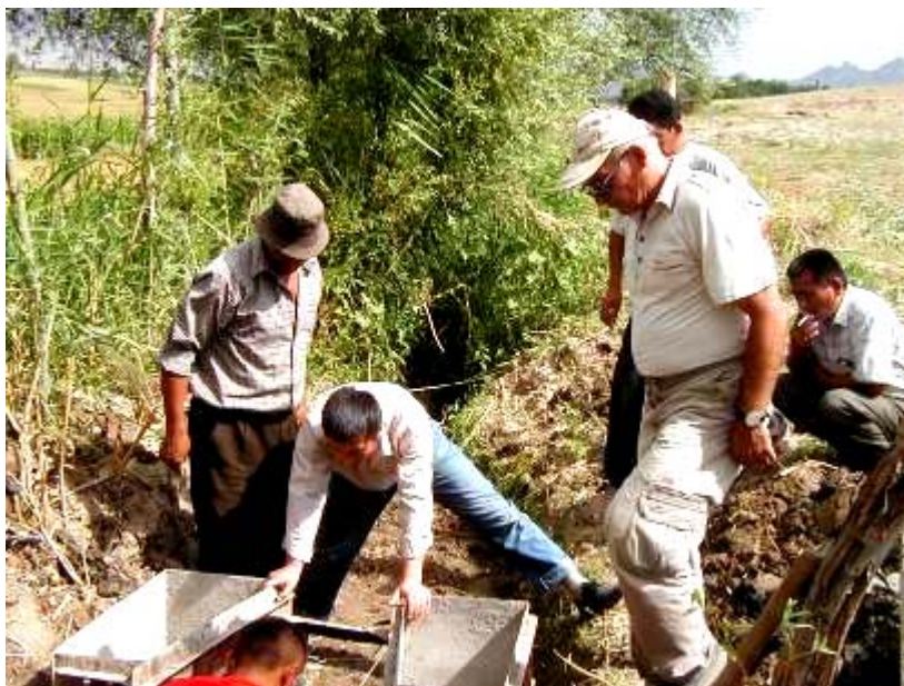
Рис.6. Установка металлической опалубки для отливки лотка САНИИРИ
