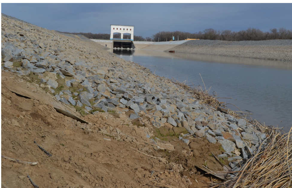
Рисунок 3 – Участок ДМК с противофильтрационным экраном из бентоматов
