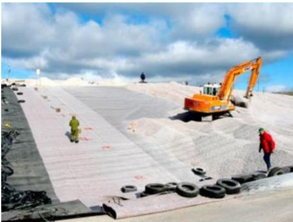
Рисунок 4 – Реконструкция накопителя отходов с применением геосинтетических материалов
