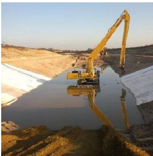
Рисунок 2 – Реконструкция оросительного канала в г. Зенфтенберг
