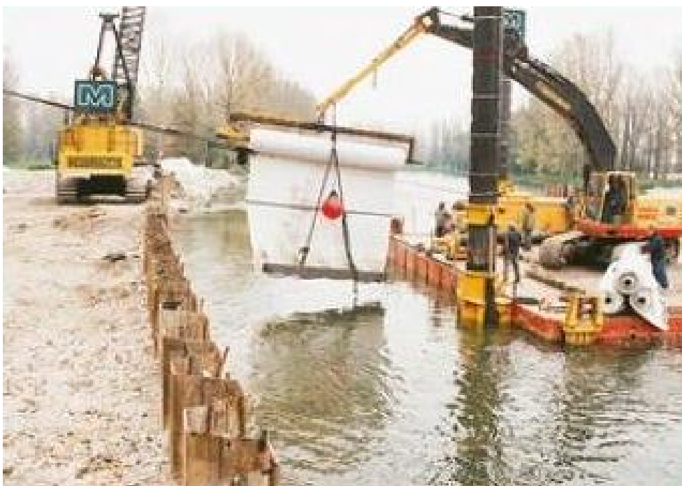
Рисунок 1 – Укладка бентоматов в канал Дортмунд-Эмс
