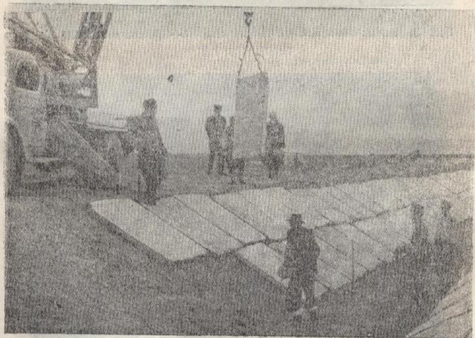
Рис. 14. Предварительная укладка железобетонных облицовочных плит на канале ЮР-16 в совхозе им. Г. С. Титова.
