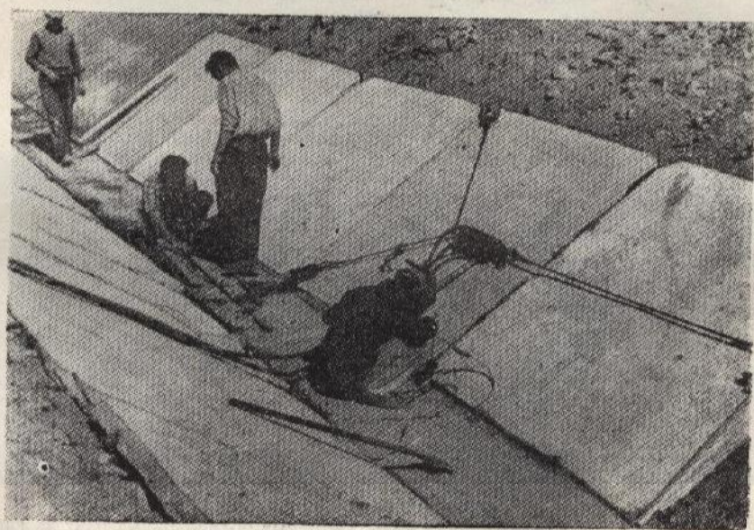
Рис. 16. Стягивание плит силовыми цилиндрами на канале 5-1-Х.
