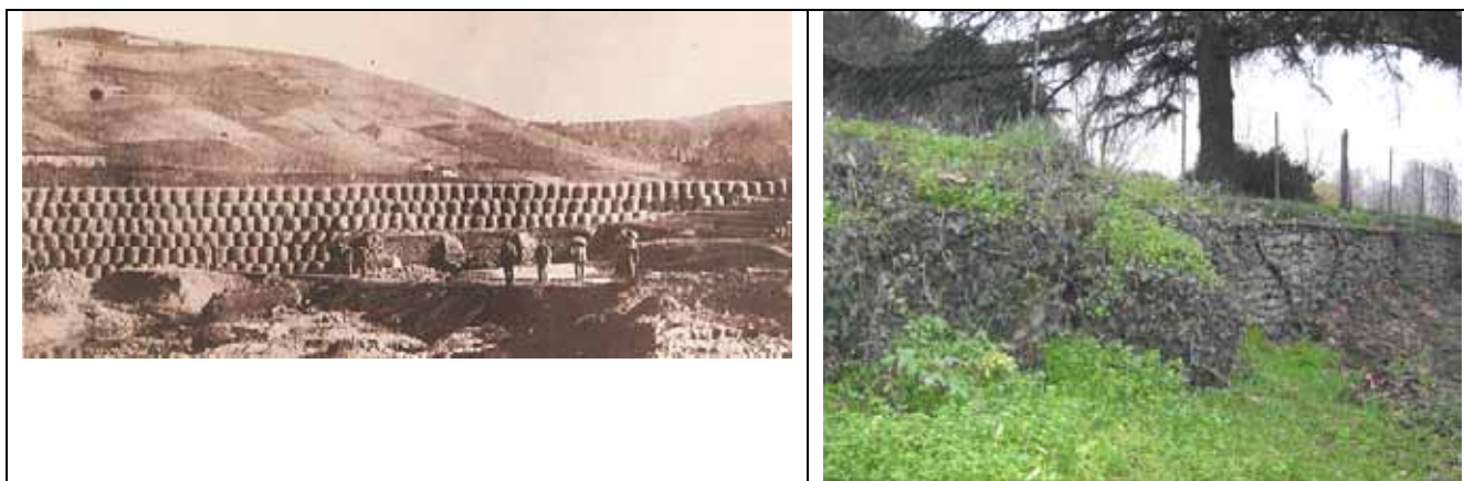
Рис. 1. Первый объект с использованием габионов
