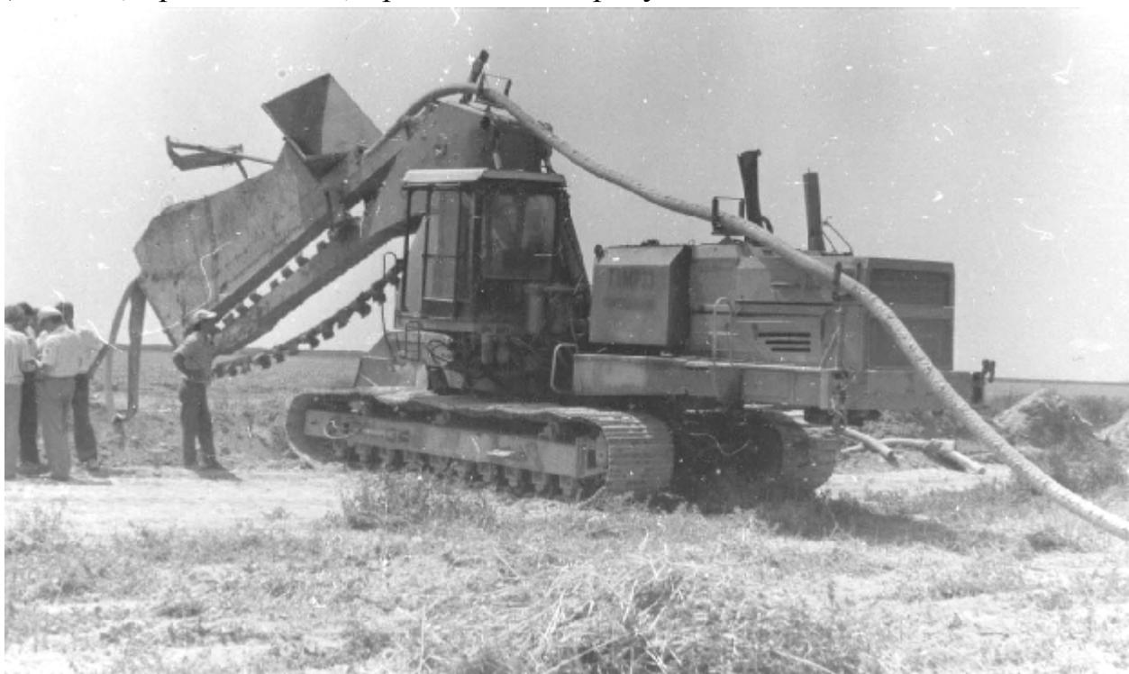
Рисунок 1- Общий вид дреноукладчика «Арал» (ДУ- 4001)
