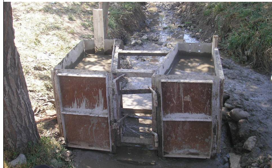
Заливка опалубки ВЛС бетоном на месте
