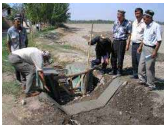
Рис 2. Обучение фермеров строительству гидропоста
