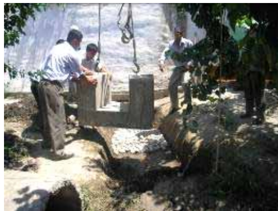
б) монтаж лотка ВЛС заводского изготовления
