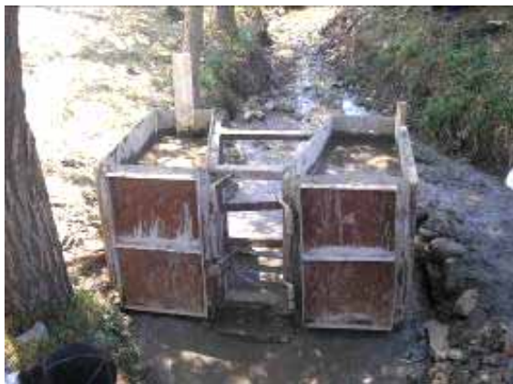
а) на месте при помощи переносной опалубки
