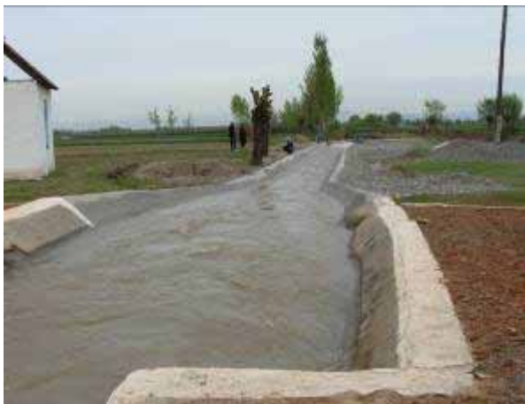
Завершенный головной участок канала
