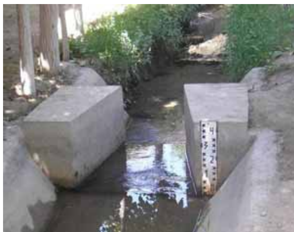
Рис. 6. Водомерный лоток САНИИРИ 1 – входные открылки, 2- гидротехническая рейка.
