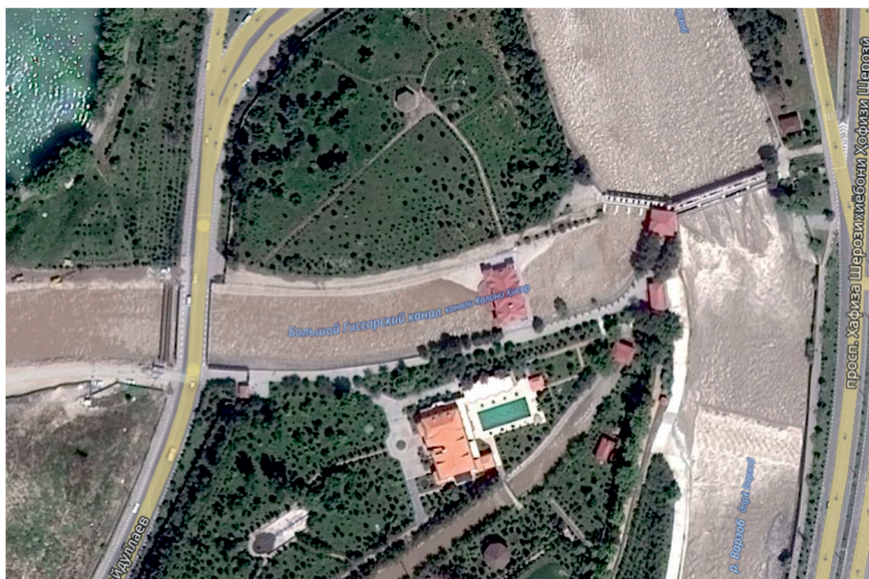
Рис. 1. Водозаборное сооружение БГК
