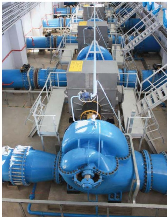
Машинный зал головной насосной станции машинного канала Иылгынагыз с насосными агрегатами Д 12500 - 10 М2
