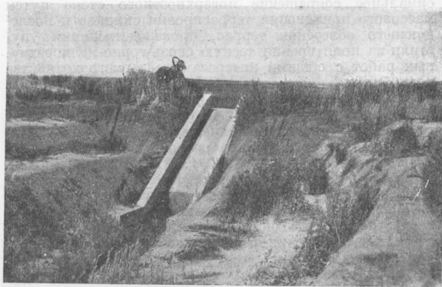
17. Вершинное овраго-укрепительное сооружение (каменно-бетонный быстроток).
