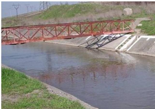
**Рисунок 2 – Гидрометрический створ в фиксированном русле открытого канала, Республика Узбекистан<sup>6</sup>**
