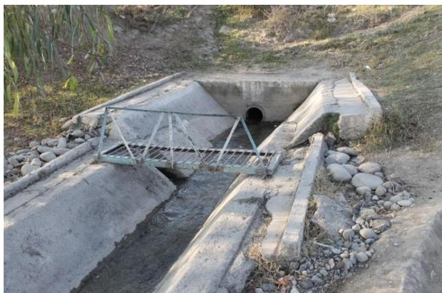
**Рисунок 3 – Гидропост типа «фиксированное русло» на сбросе в р. Араван-Сай, Киргизская Республика<sup>7</sup>**
