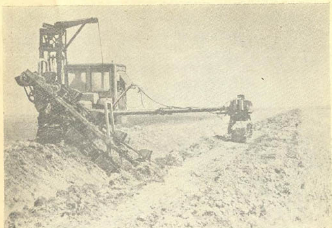
Рис. 13. Многоковшовый экскаватор ЭМ-152А в работе (Генераловская оросительная система).
