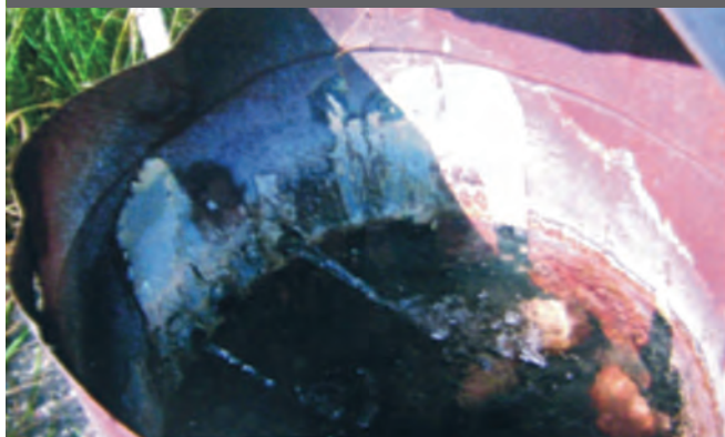
Резервуар, внутренний вид
