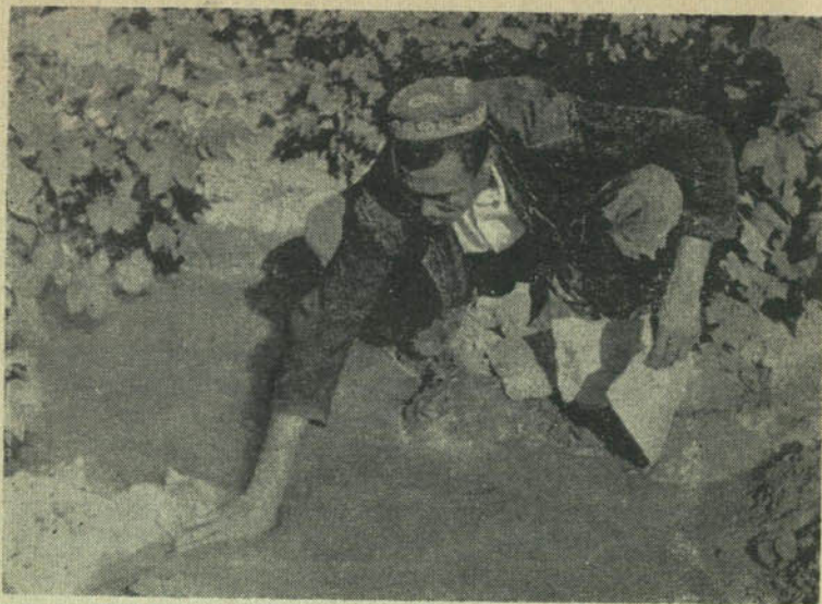
Рис. 6. Поделка перемычки на оросителе с облицовкой из бумажных салфеток.
