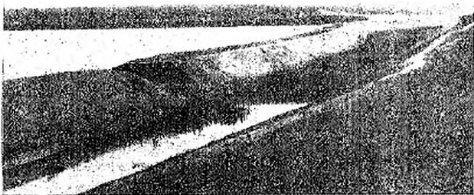
Прорѣзъ дамбы въ мѣстѣ временнаго пропуски воды изъ канала Императора Николая I въ магистральный каналъ (на 29-ой верстѣ его). За дамбою — искусственное озеро — осадочный бассейнъ для захвата наносовъ канала Императора Николая I.
