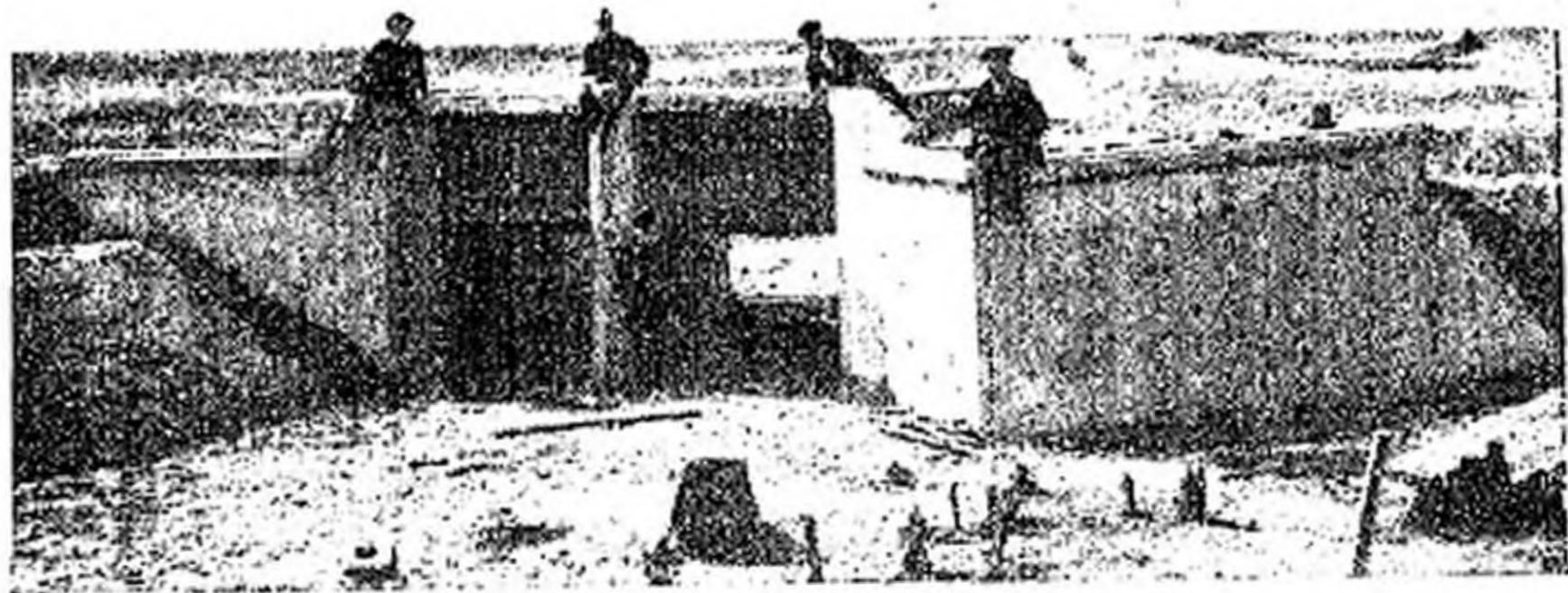
Головной выпускъ (изъ бетона и желѣзобетона) Шурь-Узякского распредѣлителя (на секунднй расходъ около 0,5 куб. саж.) на 12-ой верстѣ правой вѣтви.
