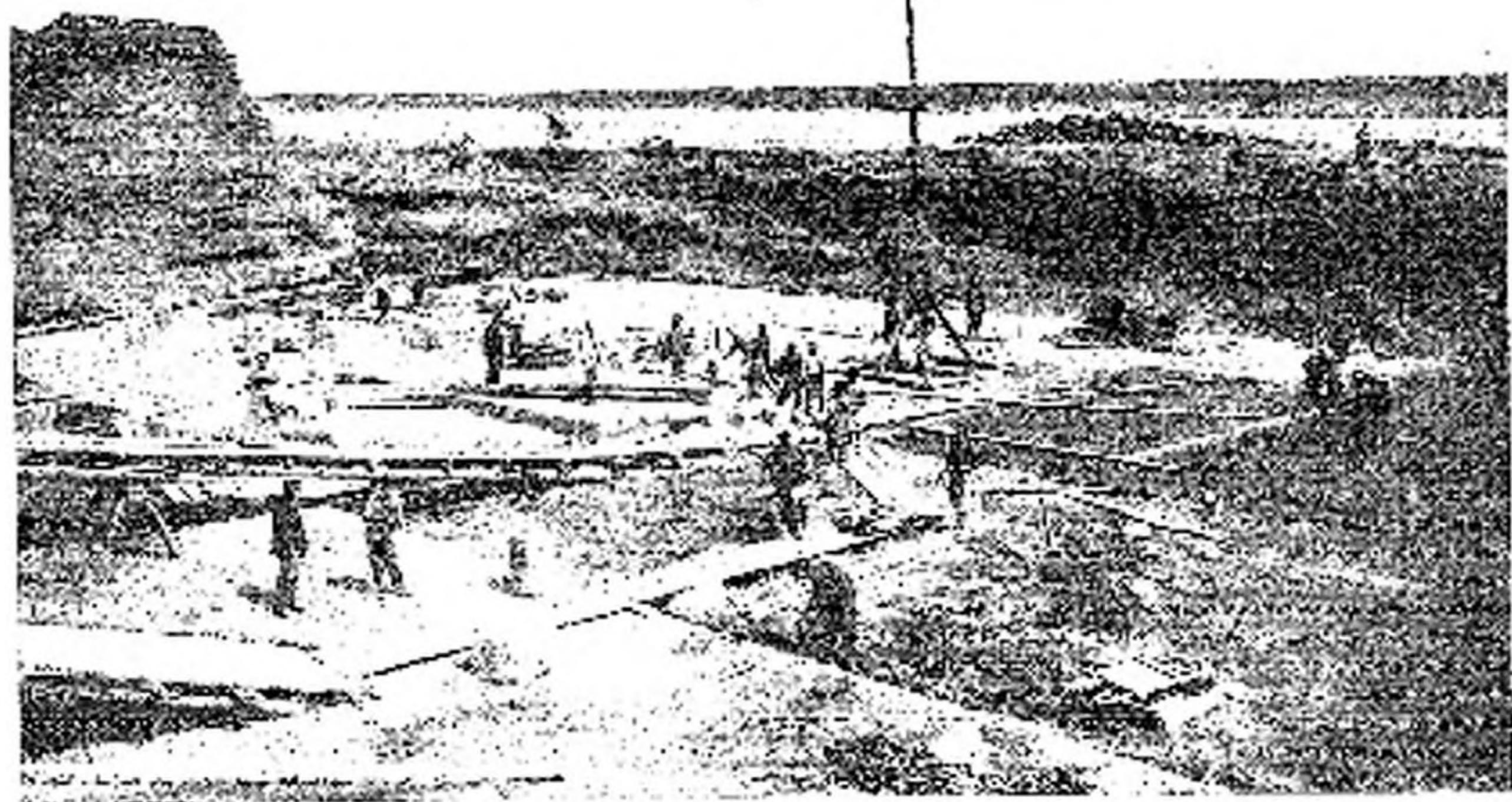
Бетонирование фундамента и начало кладки флюидбета головного устройства.
