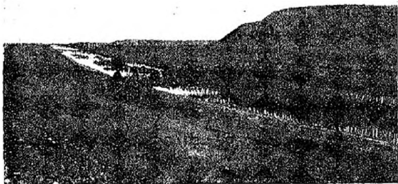
Законченная выемка магистрального канала на 16-й верстѣ. Видъ съ праваго берега вверхъ по теченію. За каналомъ видны выступы обрыва древняго берега („Кіата“), вдоль котораго проведенъ каналъ. Осень 1909 года.
