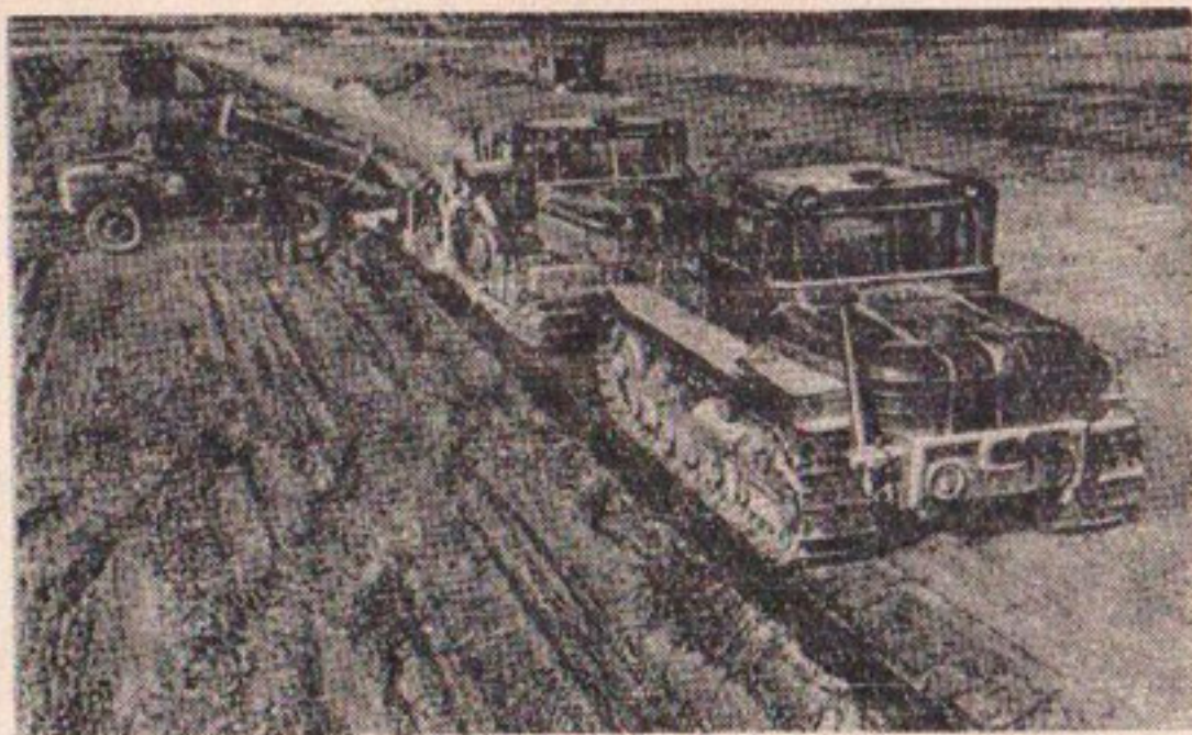
Рис. 5. Бестраншейный дреноукладчик БДМ-301А в работе.
