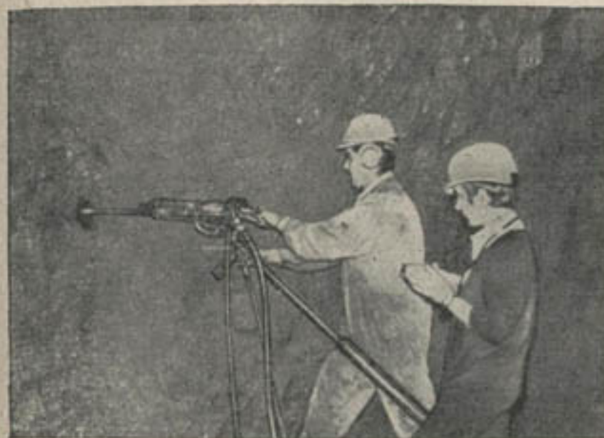
Рис. 23. Измерение шума при туннельной проходке.
