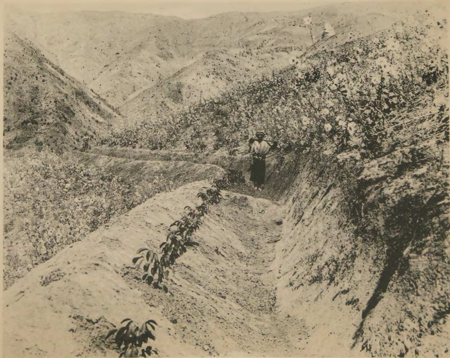
Терраса по горному склону въ 20° съ посаженными по валу террасы 1-лѣтними саженцами грецкаго орѣха.
