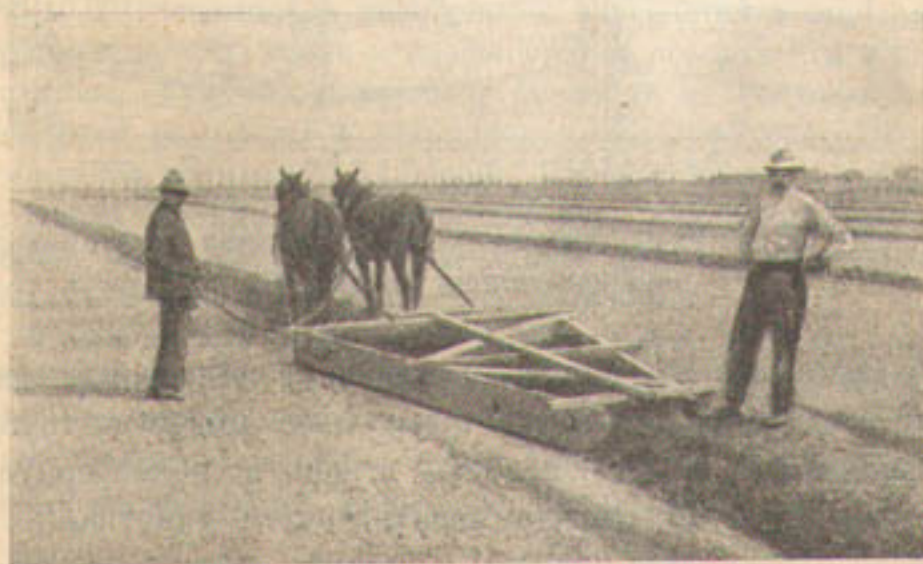
Фот. VIII. Подготовка поля для напуска полосами. Устройство валиков. Twin falls, Айдаго. Farm. Bull., № 1243.
