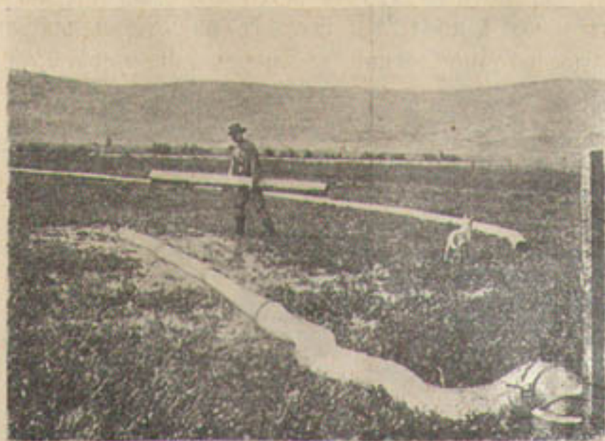
Фот. IX. Орошение люцерны переносными трубами. (Справа в углу виден гидрант, подающий воду из подземного трубопровода. В. А. Etcheverry)
