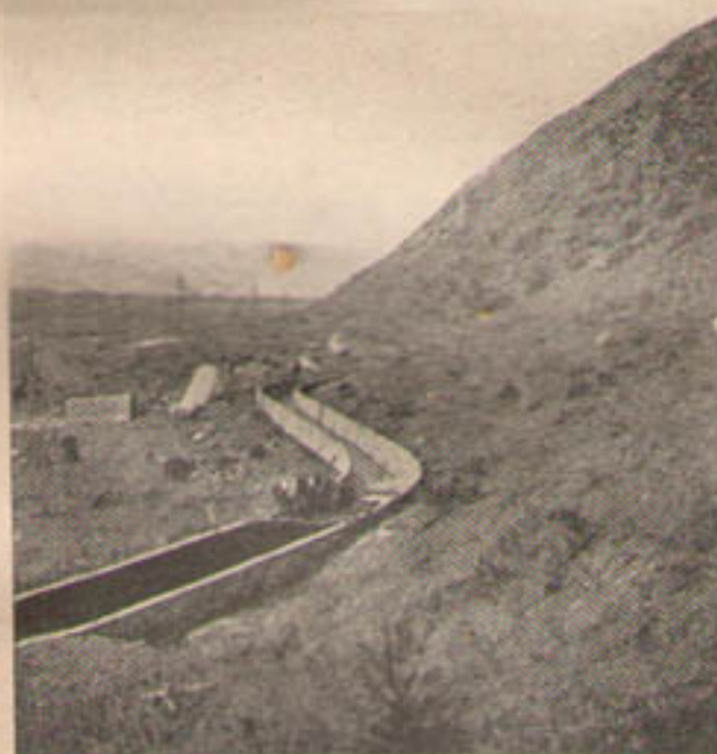
Фотогр. VII. Железобетонный лоток, огибающий холм (опирается непосредственно на грунт).
