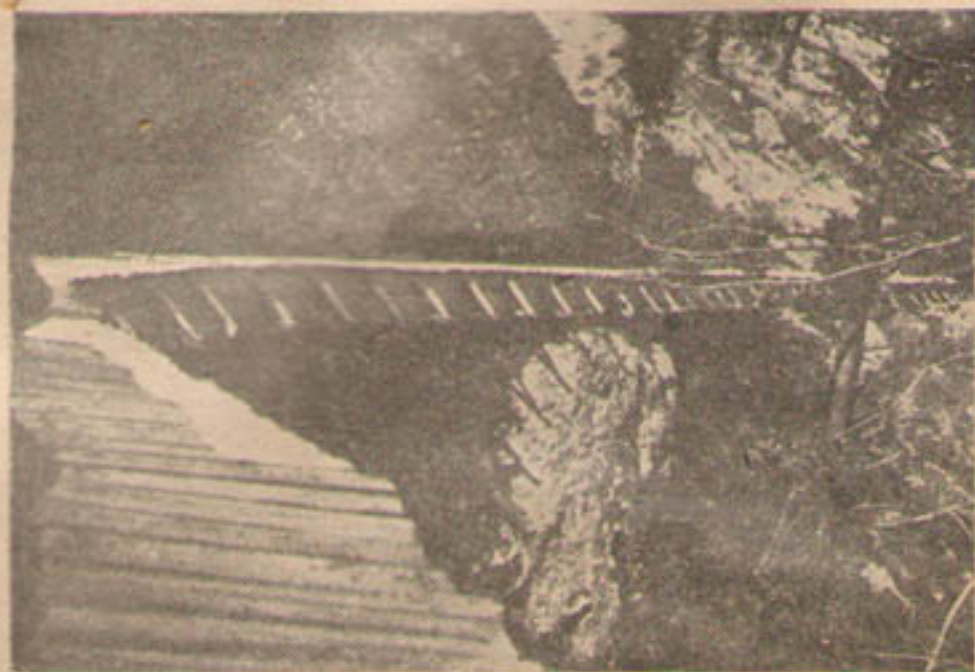
Фотогр. III. Маленький деревянный лоток на консолях. (С. III. С. Америки. Система Пентиктон).
