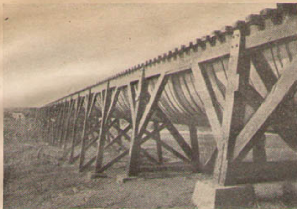
Фотогр. VI. Переход лотком (металлическим) кругового сечения, на деревянных опорах, через низкое место (вместо насыпи).
