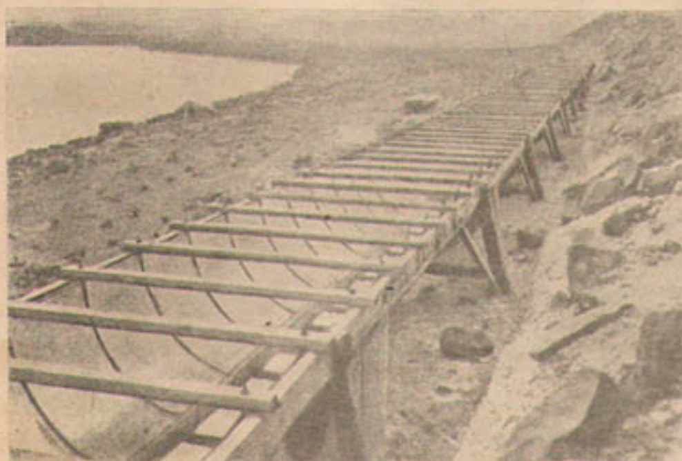
Фотогр. V. Лоток (металлический) диаметром в 2,13 метра (7саж.). (С. Ш. С. Америки, шт. Айдахо. Система Моунтен Хом.).
