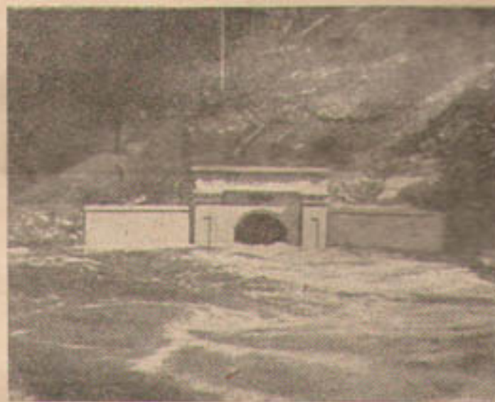
Фотогр. II. Выход из туннеля.
