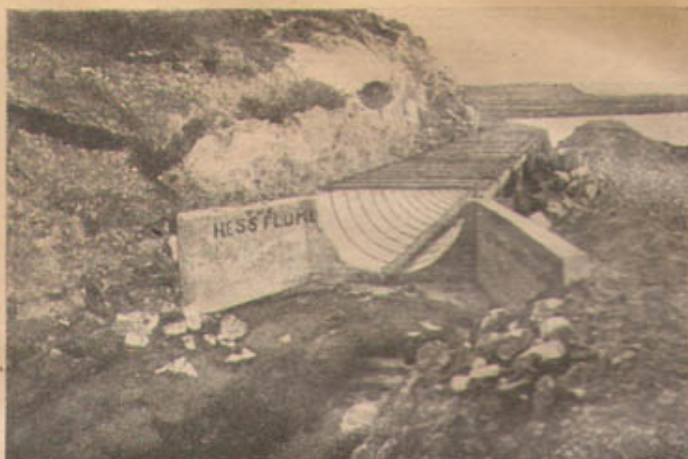
Фотогр. IX. Переход канала в лоток (металлический) (С. Ш. С. Америки, шт. Айдаго. Система Свэк Ривер).
