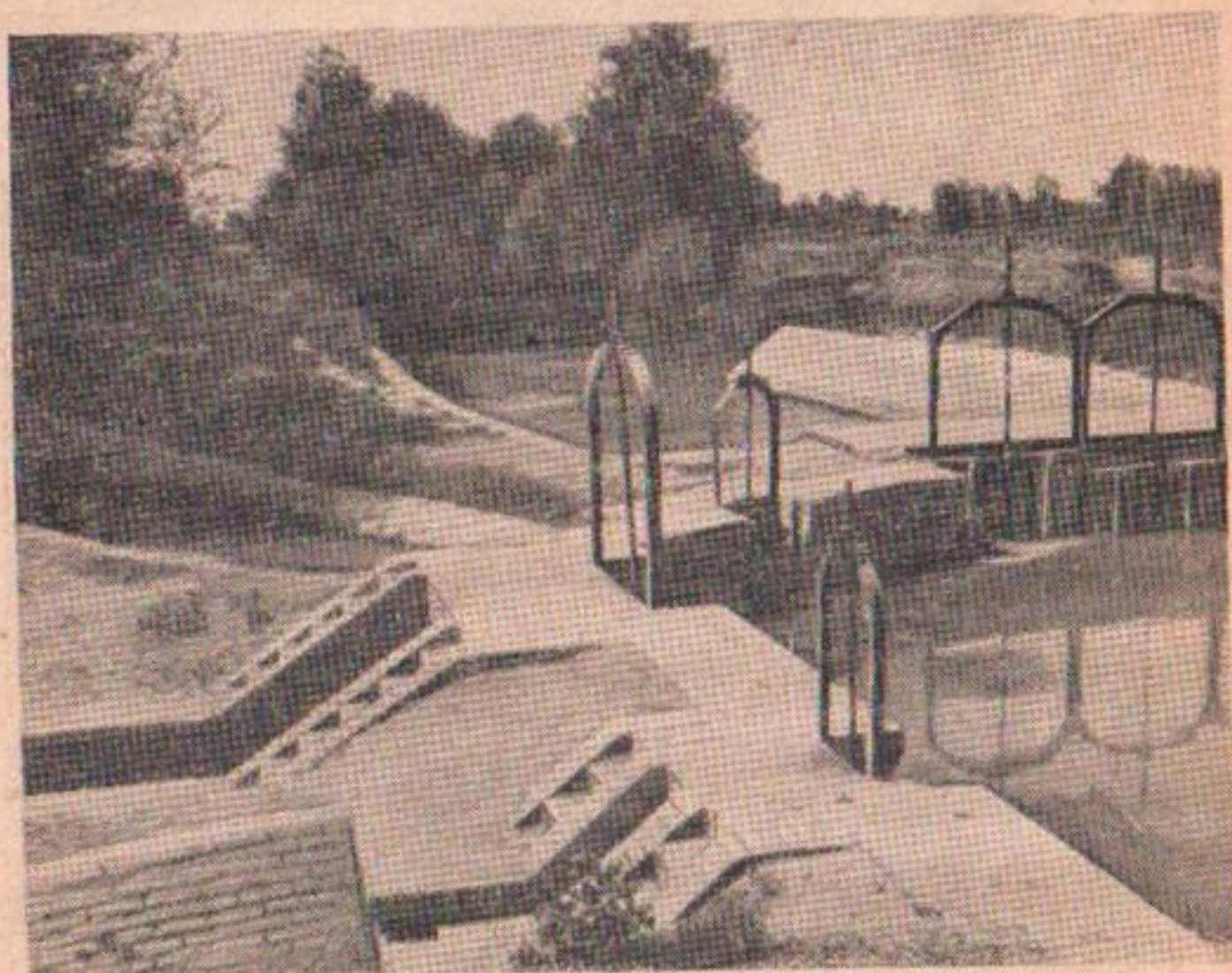
Рис. 8. Бетонное вододелительное сооружение.
