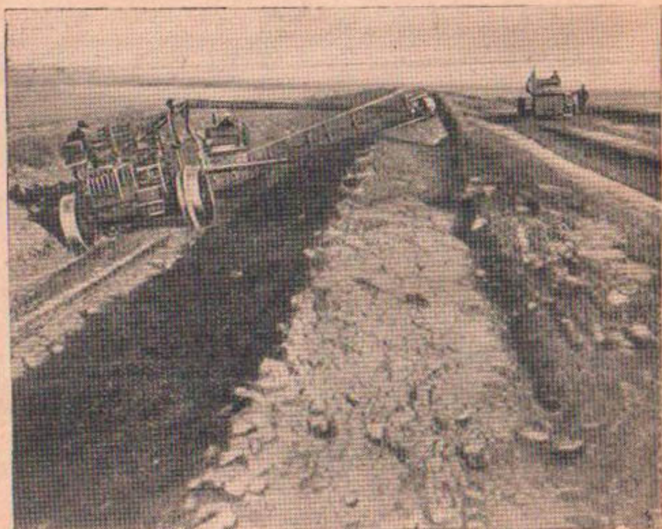
Рис. 42. Грейдер-элеватор на постройке крупного канала.
