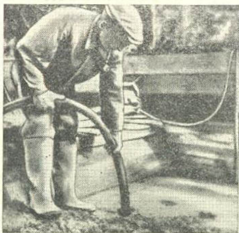
Рис. 13. Вибрирование бетона высокочастотным вибратором
