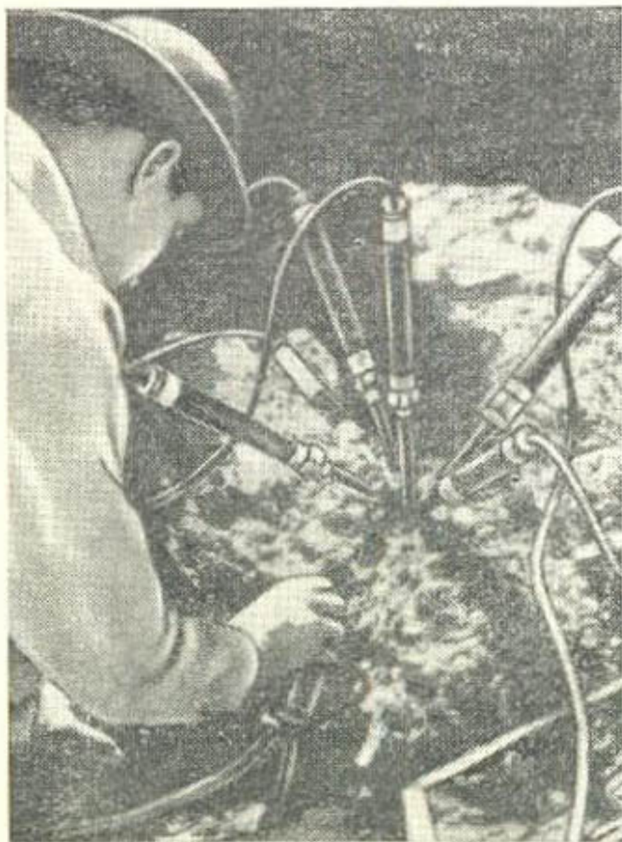
Рис. 50. Плотина Шаста. Монтаж тензометра
