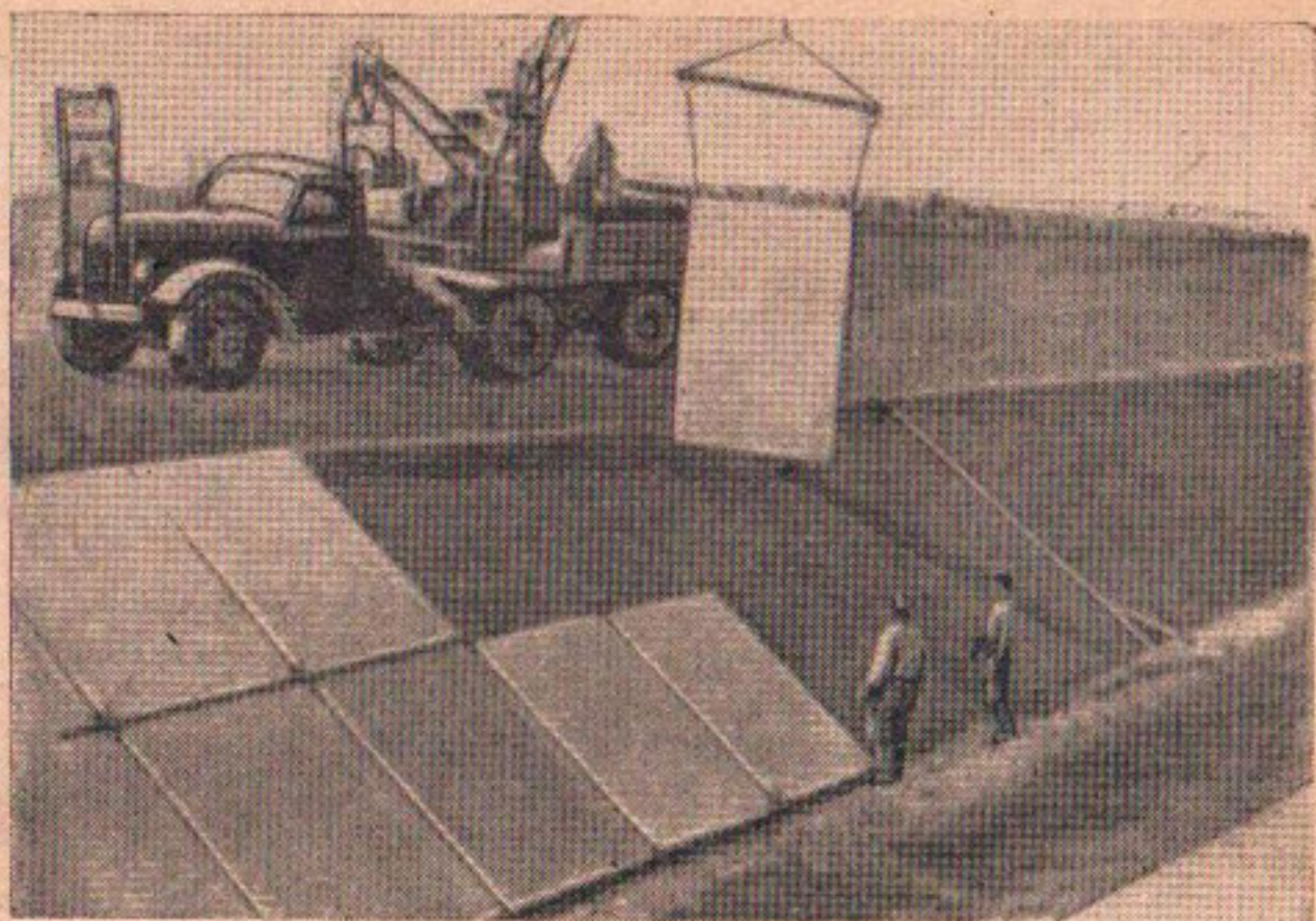
Рис. 53. Укладка плит автокраном.
